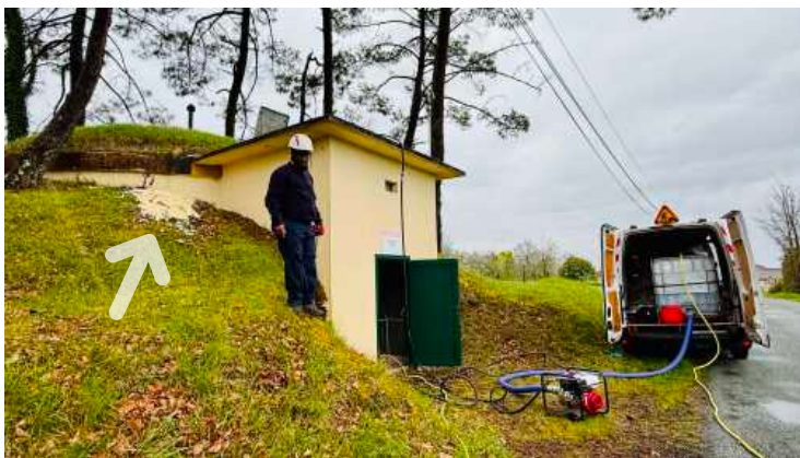
Le syndicat d'eau Véolia a effectué une purge du château d'eau route du Maine. Un gros tas de calcaire a été prélevé.
