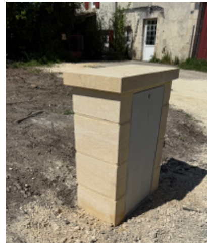
Le syndicat d'électricité a aménagé le réseau à la Sénédie. Les coffrets sont habillés en pierre, les lignes enterrées et les poteaux supprimés.
