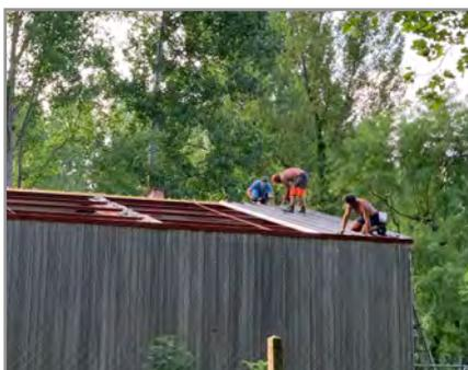
Réfection de la toiture du bâtiment du hangar communal suite à la tempête de grêle du 20 juin 2022 en panneaux sandwichs pour plus d'isolation afin d'éviter la condensation. Le coût des travaux a été pris en charge par l'assurance.
