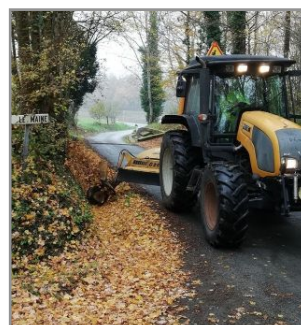
Curage des fossés
