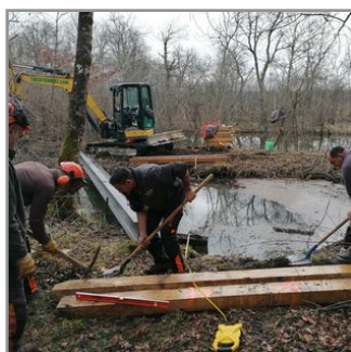
Travaux aux Tourbières de Vendre
