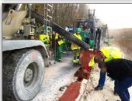
Sur le chantier à Bussac : Installation du câble pour la fibre optique. Bussac est la première commune du secteur à être connectée au haut débit. Celui-ci est prévu à Lisle pour la fin 2017
